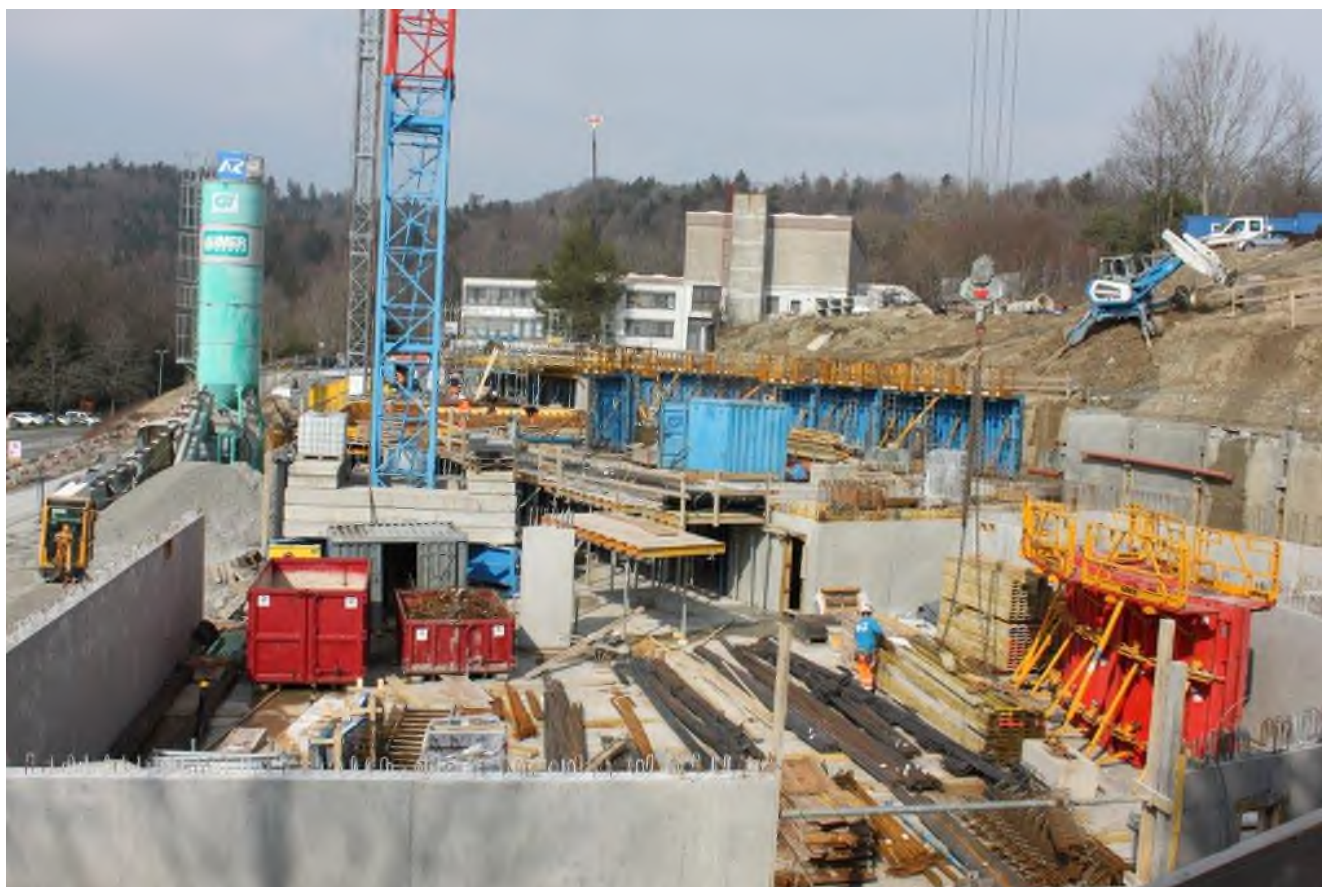
Chantier PQ Arnier II
