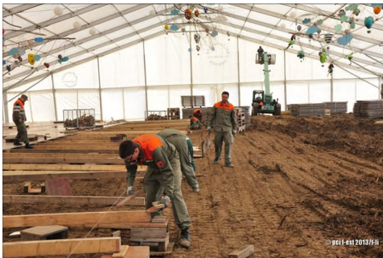
FCMV à Savigny montage des structures cantine
