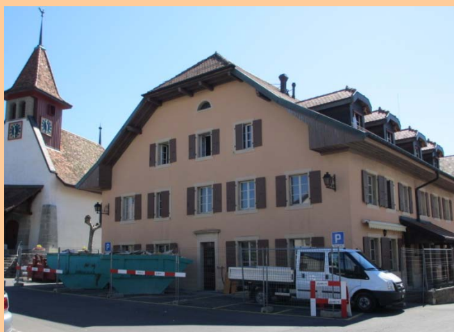
Avant les travaux
