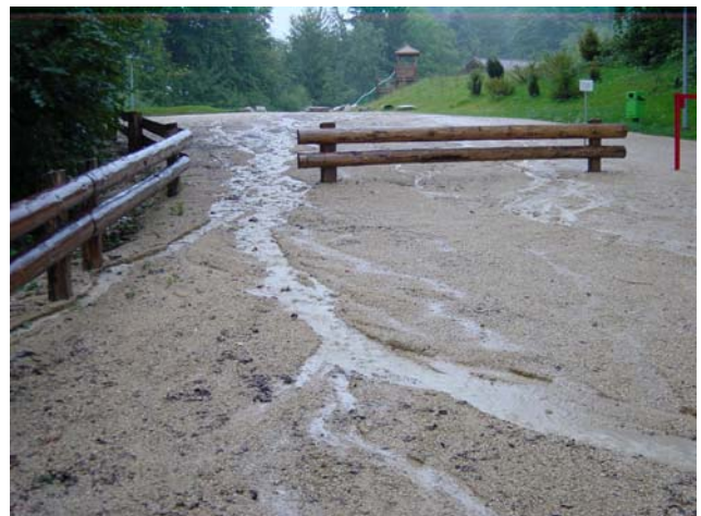
Orage d'été – dégâts aux Bas-Monts
